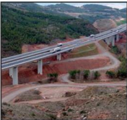
Viaducto en la A-23
