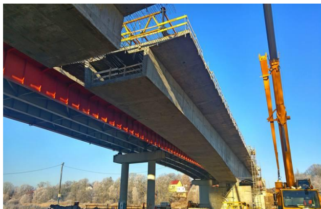
Dokończenie drogi s3
